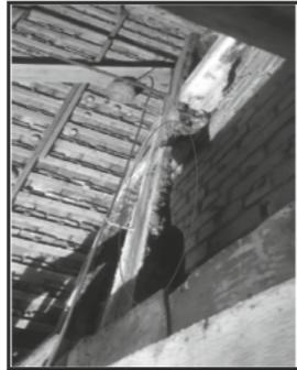
In einer Voruntersuchung mit Schadenskartierung der Zimmerei Schatz GmbH aus Pfullendorf-Denklingen wurde ein Sanierungskonzept für die Holzbauteile des Dachtragwerks bzw. der darunter liegenden Deckenbalken, sowie der Dachdeckung erstellt. Beim Giebelmauerwerk sollten vorgenommene Sanierungsversuche wieder zurück gebaut werden, so wurde z.B. die Nische für die Giebelpfosten zugemauert.
