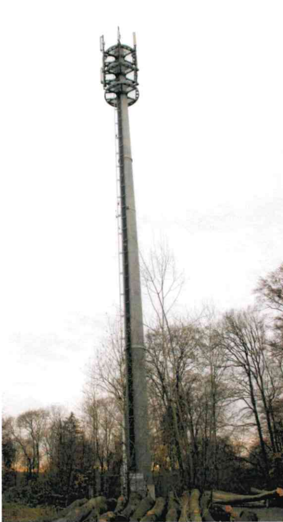
Bildbeispiele von ca. 45 - 60 m Schleuderbetonmasten
