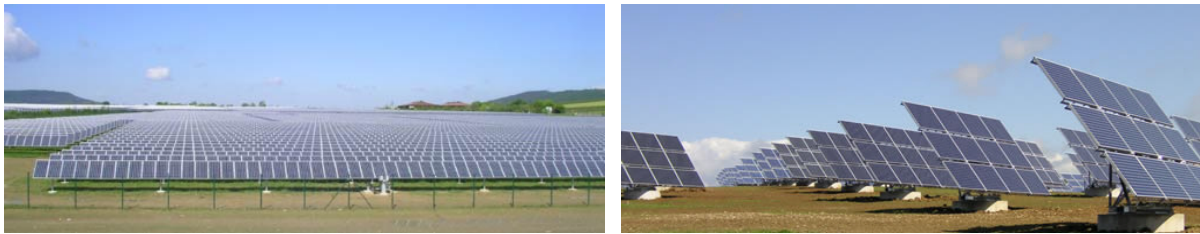
Abbildung 15: Beispiele für die Aufständigung von PV-Modulen
