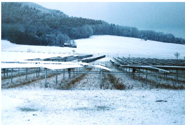
Abbildung 23: Schneefreie Bereiche unter Modulen in Mühlhausen
