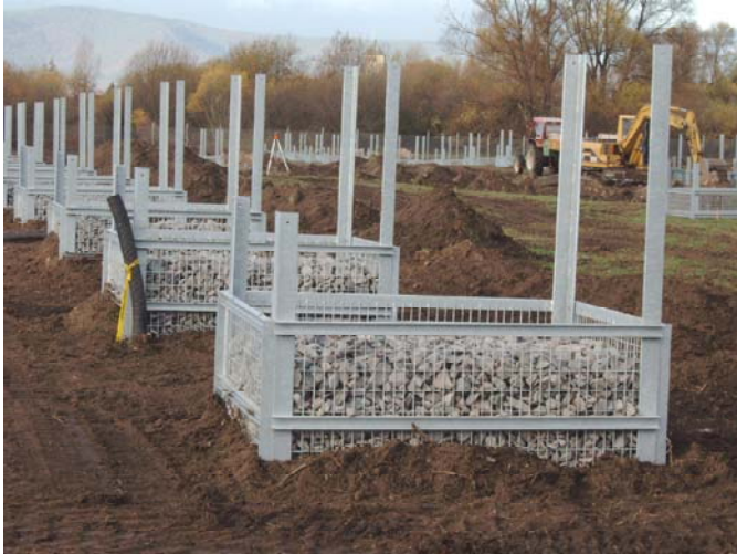
Abbildung 50: Beispiel für ein Gabionenfundament (Steine in Stahlkorb)
