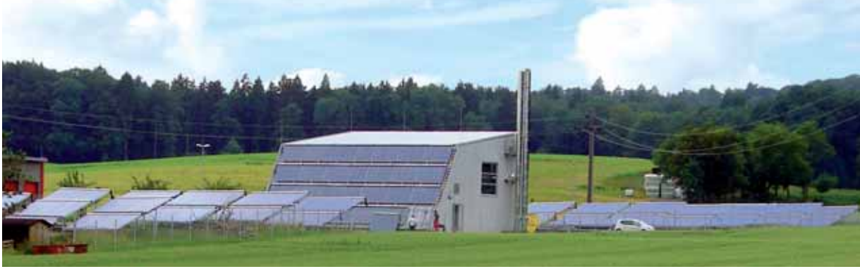
BILD 9: Heizwerk des Bioenergiedorfs Büsingen mit 1.090 m² Vakuumröhrenkollektoren und einem Biomassekessel.
