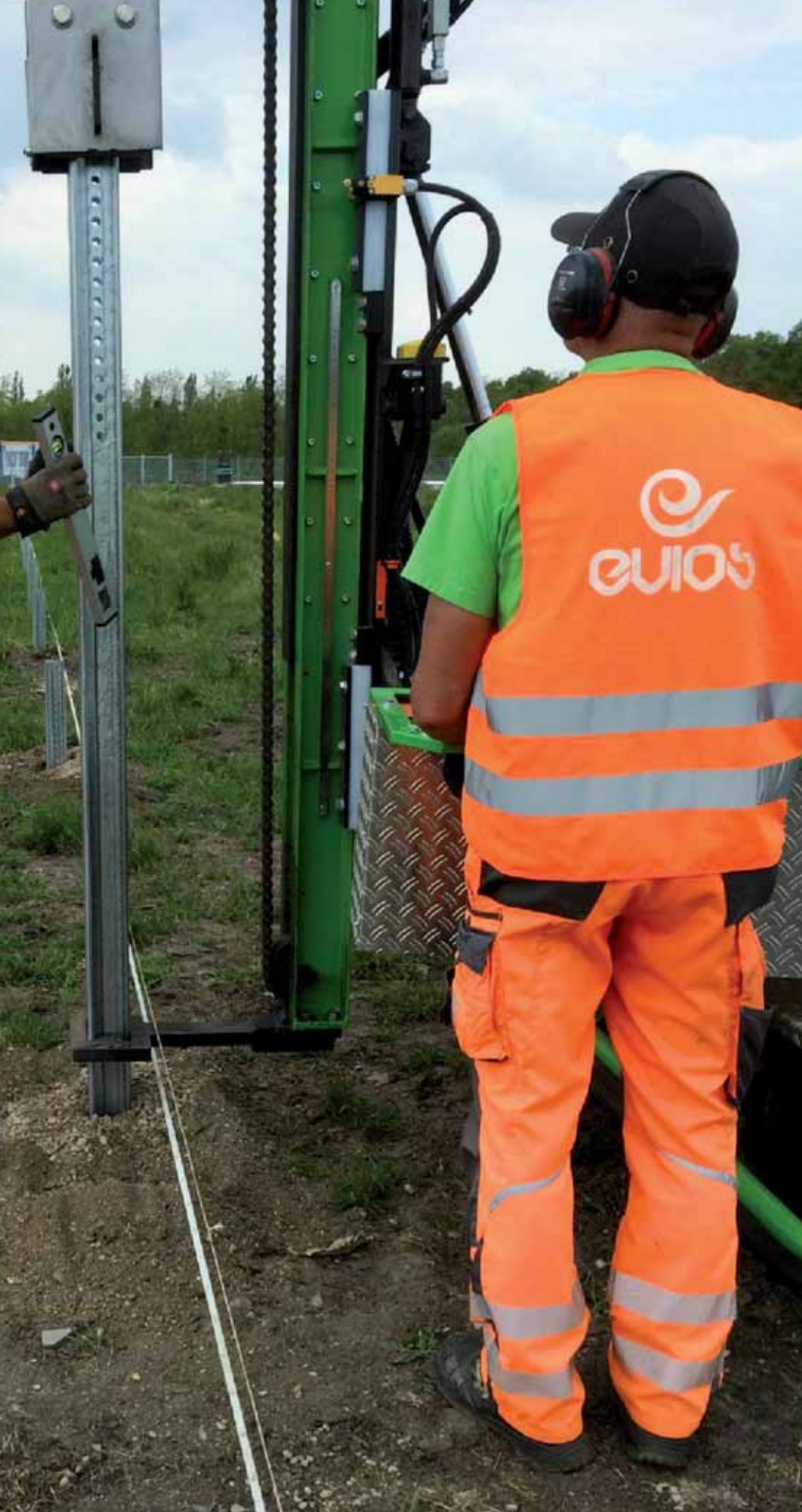
BILD 17: Einrammen der Trageprofile für eine solarthermische Anlage.
